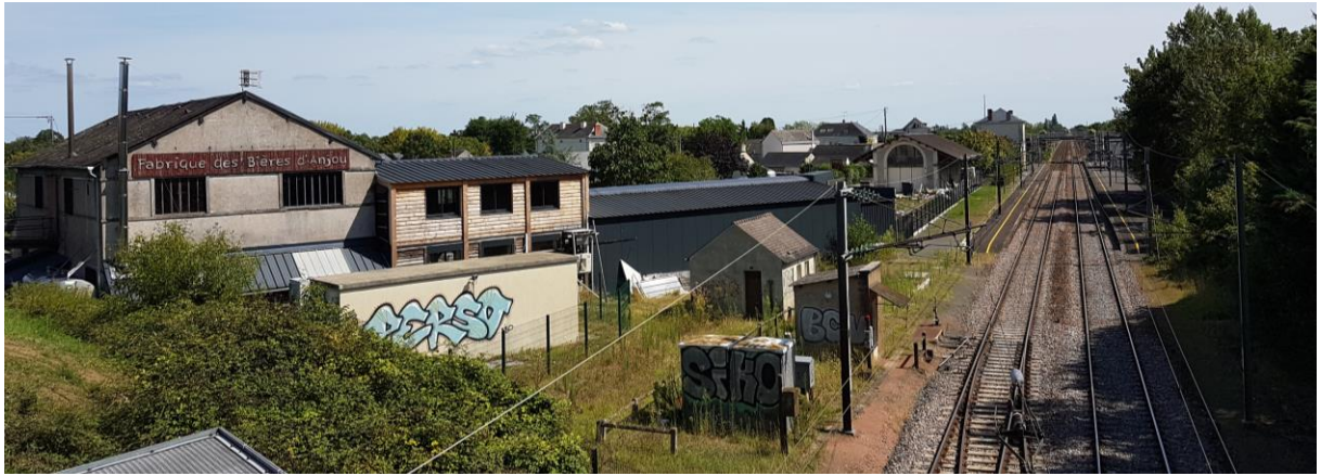
Figure 70. Passage de la voie ferrée le long du bourg de La Ménitré
