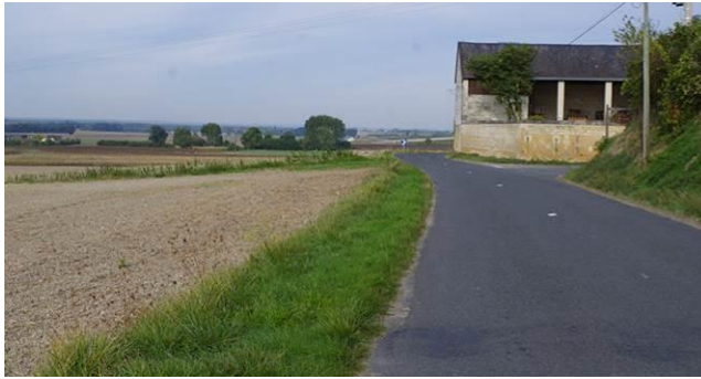
Grange. A l'entrée du hameau de la Guerche sur la D50. La grange est ajourée à l'Est permettant de protéger les récoltes des vents humides venant de l'Ouest.
