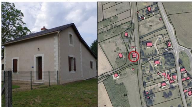
Maison de garde barrière
