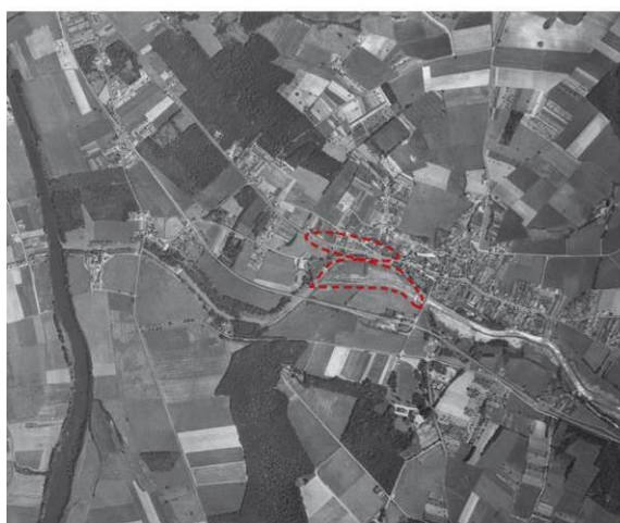
Photographie aérienne de 1969 (ign) : Étalement urbain à l'Ouest le long de la D42. Le secteur de l'île de la Claise encore peu arboré.
