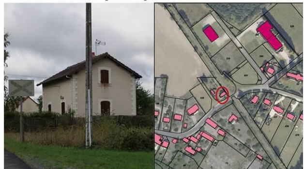
Maison de garde barrière
