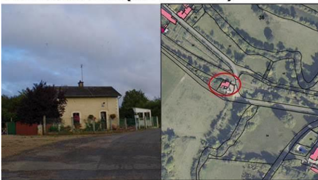
Maison de garde barrière portant le numéro 218
