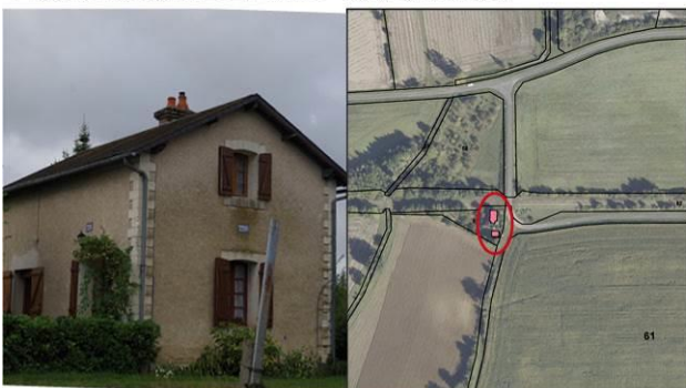
Maison de garde barrière portant le numéro 220
