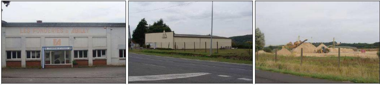
Les Fonderies – L'entreprise JLC – Le site de carrières
