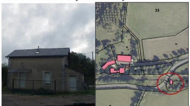
Maison de garde barrière portant le numéro 219
