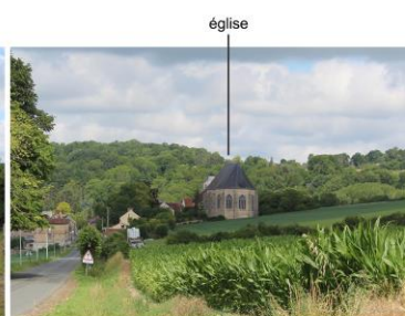
B - église de Verdelot vue depuis l'accès par le sud-est (RD31)
