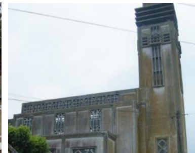
Patrimoine de la reconstruction : église de Brie
