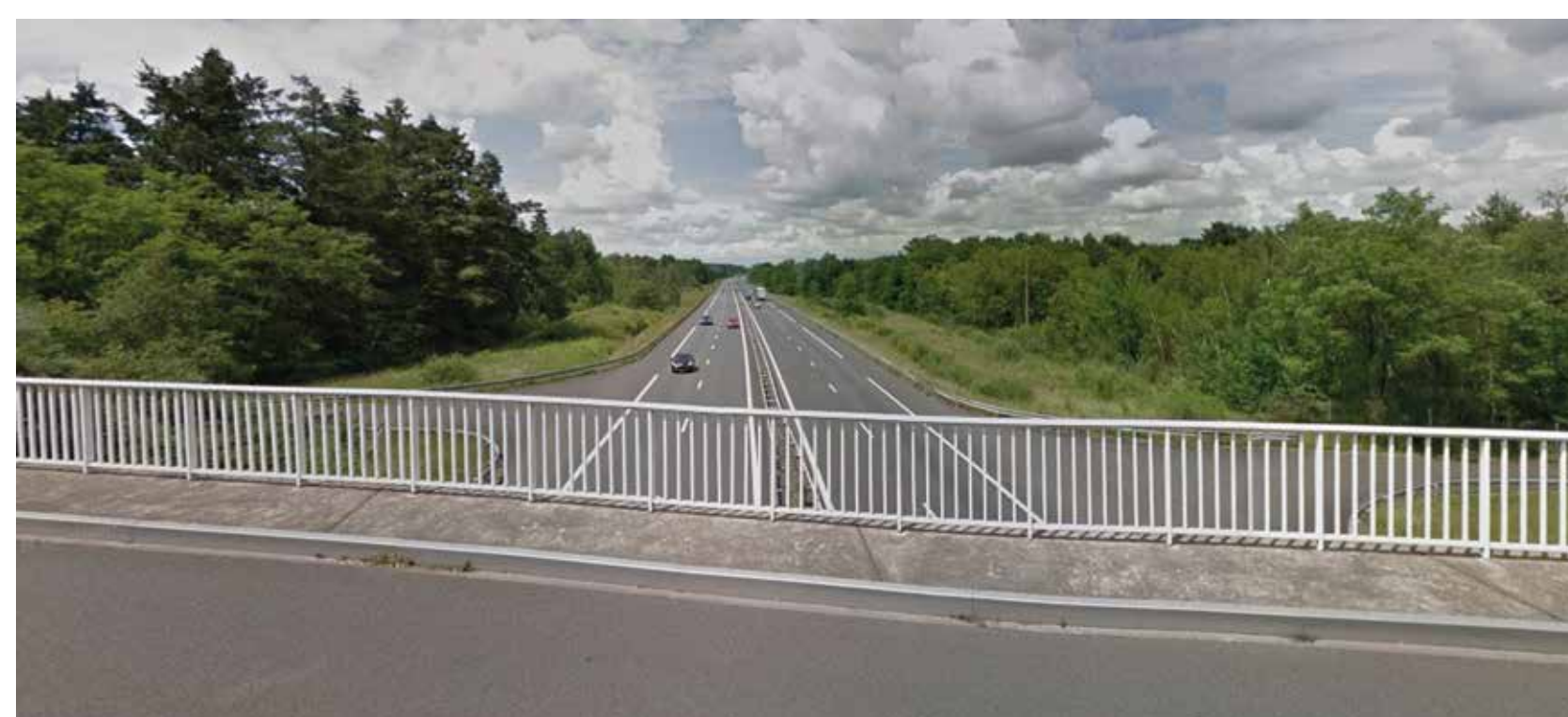
Vue sur l'A71 depuis la route de Ligny-le-Ribault - © Google
