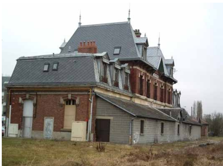
Patrimoine ferroviaire : ancienne gare de Péronne
