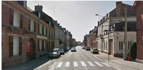
Bâti ancien structurant R+1+C à l'alignement de l'espace public
