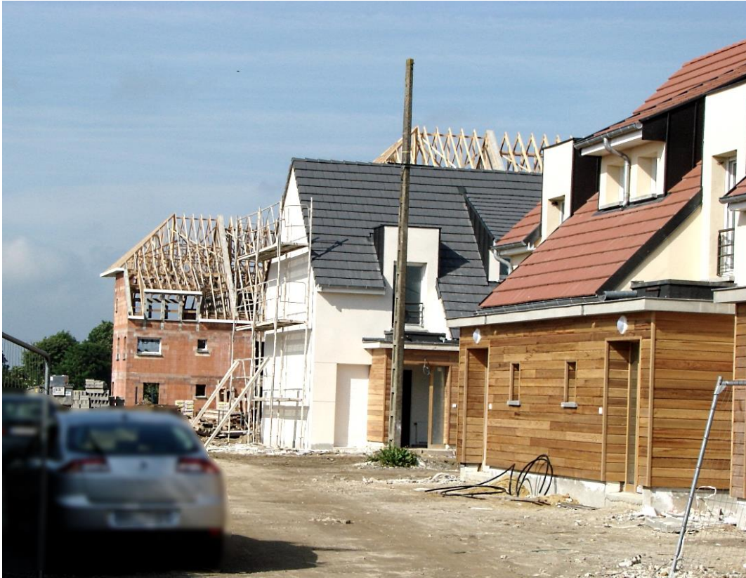
Flesselles – 2012 : chantier de 37 logements collectifs et 14 pavillons.
