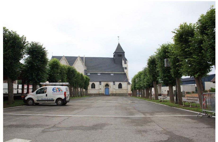
Espace public à Villers Bocage
